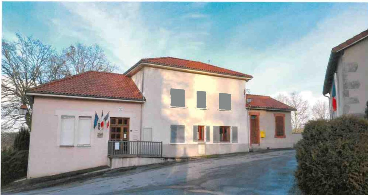
Les couvertures des toitures de la Mairie et de l'ancienne Mairie (annexe) nécessitaient d'être rénovées. En effet les tuiles très anciennes, dont une très grande quantité étaient poreuses ou cassées, provoquaient des infiltrations dans les locaux, un écran sous toiture microporeux a été posé afin de réduire les différentes infiltrations ( vent, poussières, humidité etc...)
