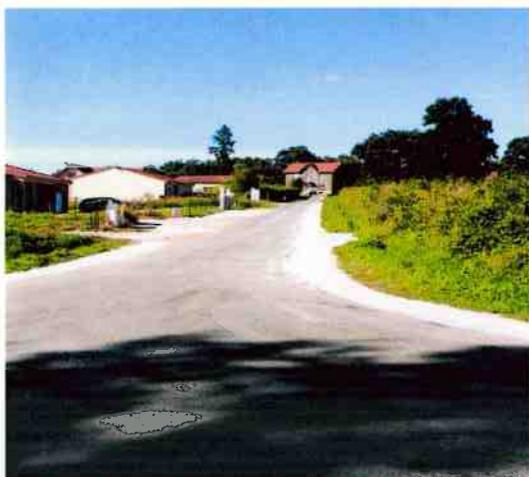
Nos voies communales, sur certains tronçons et dans le temps, ont été l'objet de travaux d'enfouissement des réseaux d'eau, d'électricité ou de téléphone. Ces travaux ont eu pour conséquence de déstabiliser les accotements et lorsque des poids lourds ou des attelages agricoles circulent sur ceux-ci ils créent des ornières. Aussi, il était indispensable de renforcer les accotements pour qu'ils redeviennent stables.
