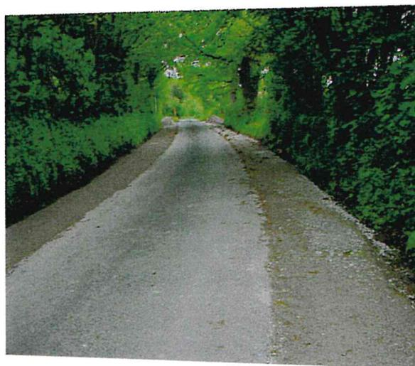
La montée du Bost était depuis pas mal de temps problématique, par temps de pluie et, notamment lorsque la route était enneigée. En effet, suite à divers travaux sur les accotements, enfouissement d'une ligne EDF à droite et réalisation du réseau d'égout à gauche, ceux-ci étaient devenus instables et les véhicules pouvaient s'embourber.
