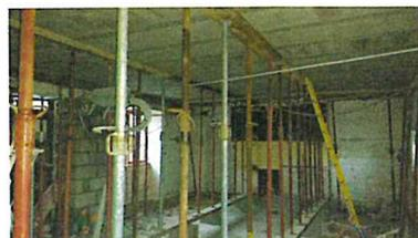
Renforcement, reconstruction , réalisation du plancher neuf de l'étage
