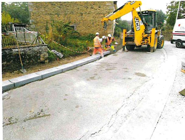
Le projet consistait à la pose de canalisations des eaux de ruissellement et par la mise en place de caniveaux concaves de chaque côté de la voie dans la partie agglomérée du village.
